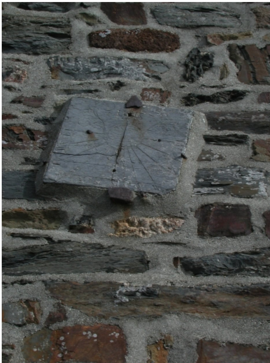
Elévation sud, transept ; un cadran solaire
