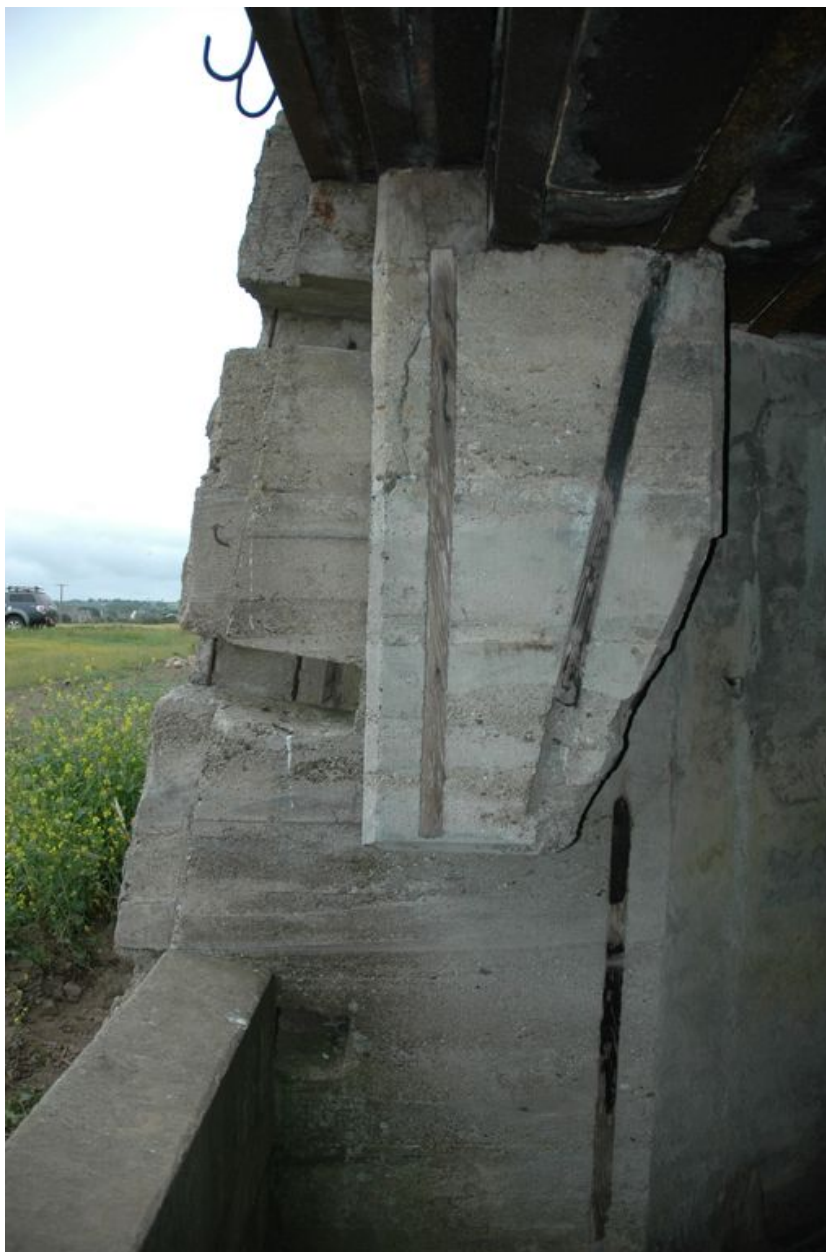
Vue de détail de l'embrasure de l'une des quatre casemates de type 669 (état en 2008)
