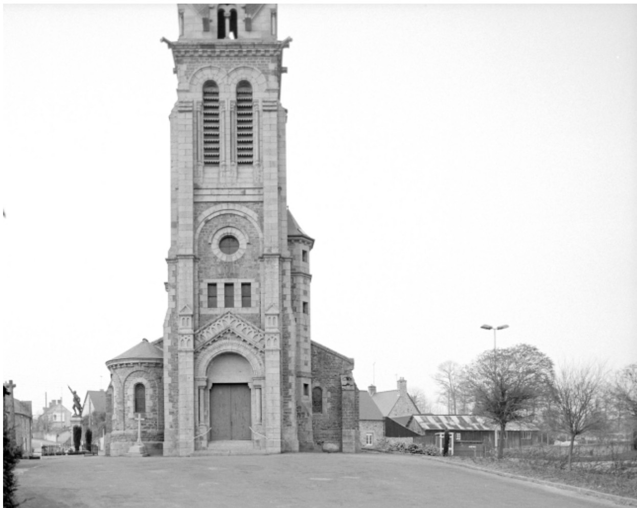
Elévation Ouest : vue générale
