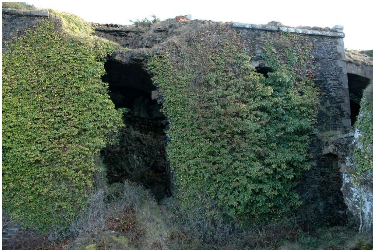
Vue générale de la caserne défensive Robert
