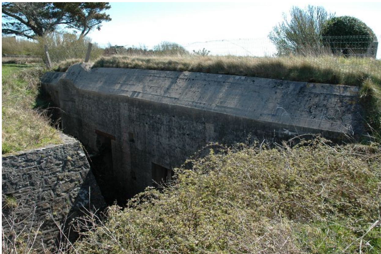
Vue de l'ensemble fortifié de la pointe du Renard : abri
