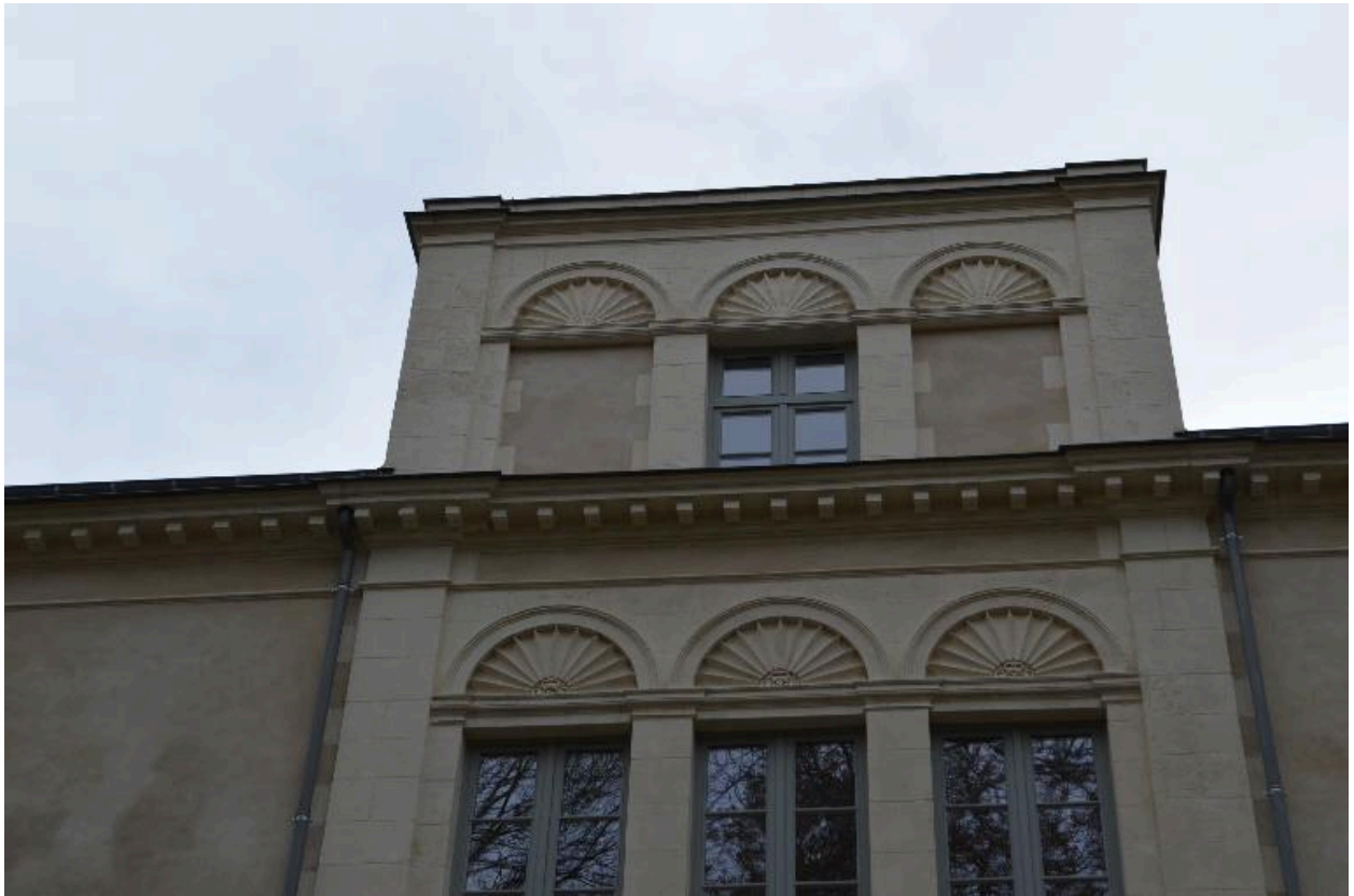
Détail de la façade nord
