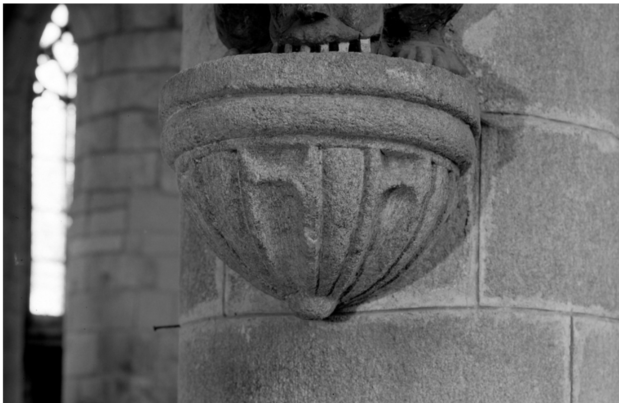
Console sur la 3ème pile sud de la nef
