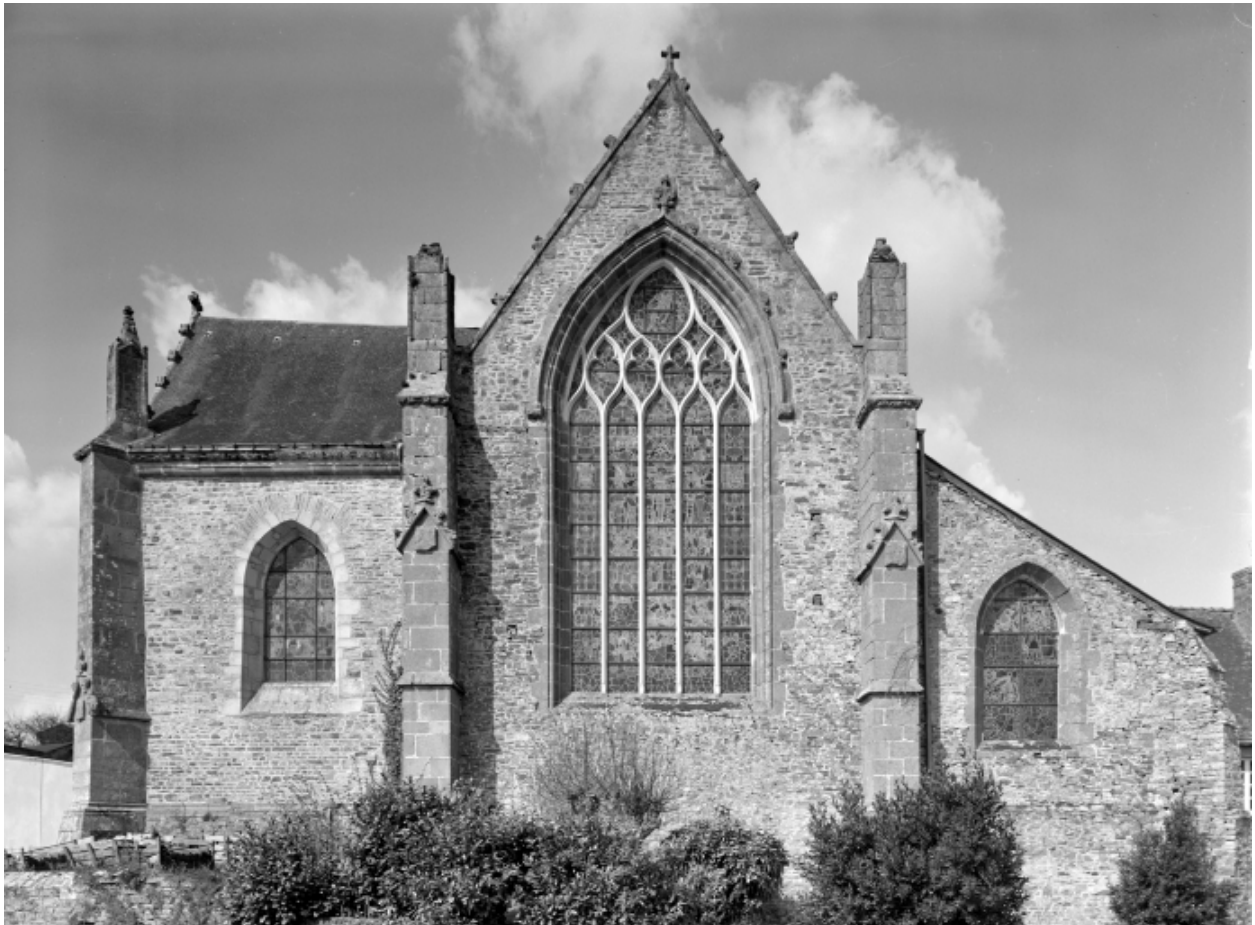
Elévation est, pignon du chevet, vue générale axiale
