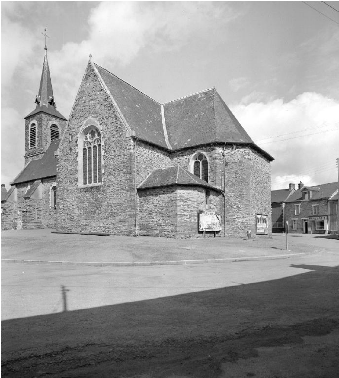
Elévation sud-est : vue générale (Etat en 1968)
