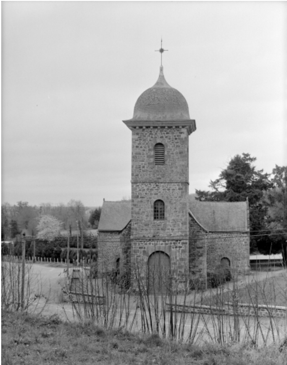
Elévation Ouest : vue générale.
