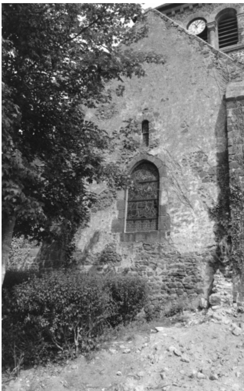
Fenêtres du bras sud du transept
