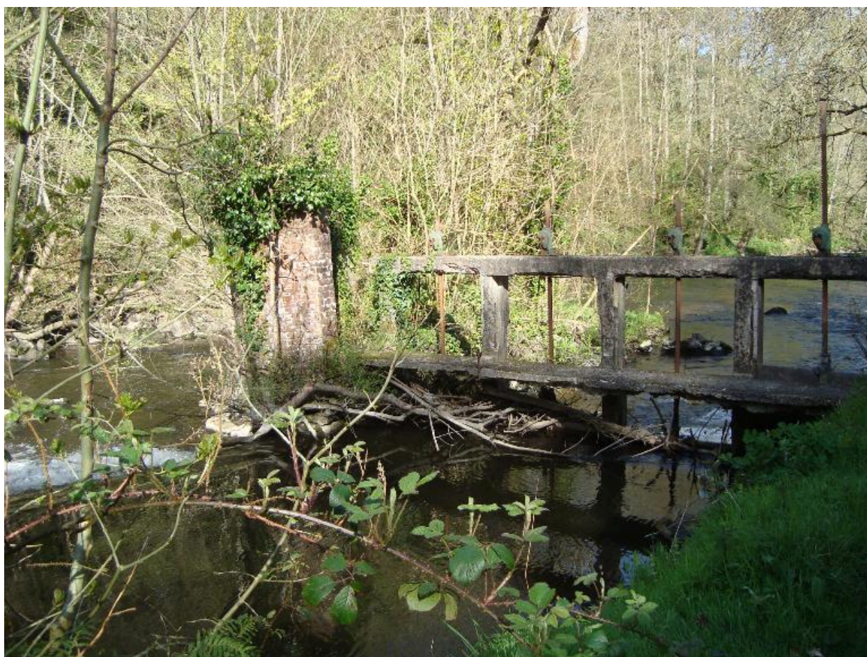
Seuil en aval de la papeterie
