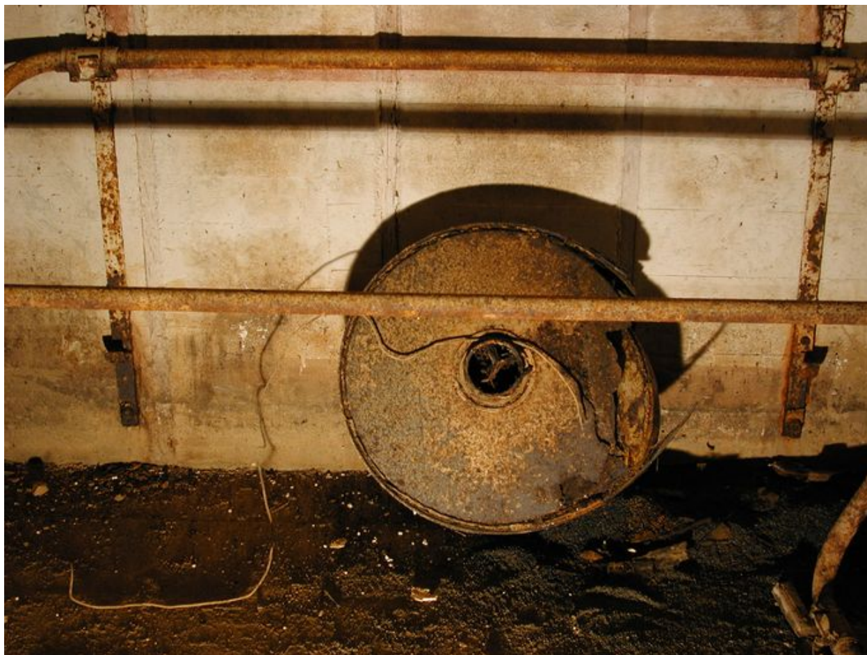
Filtre à charbon de ventilateur (à terre)
