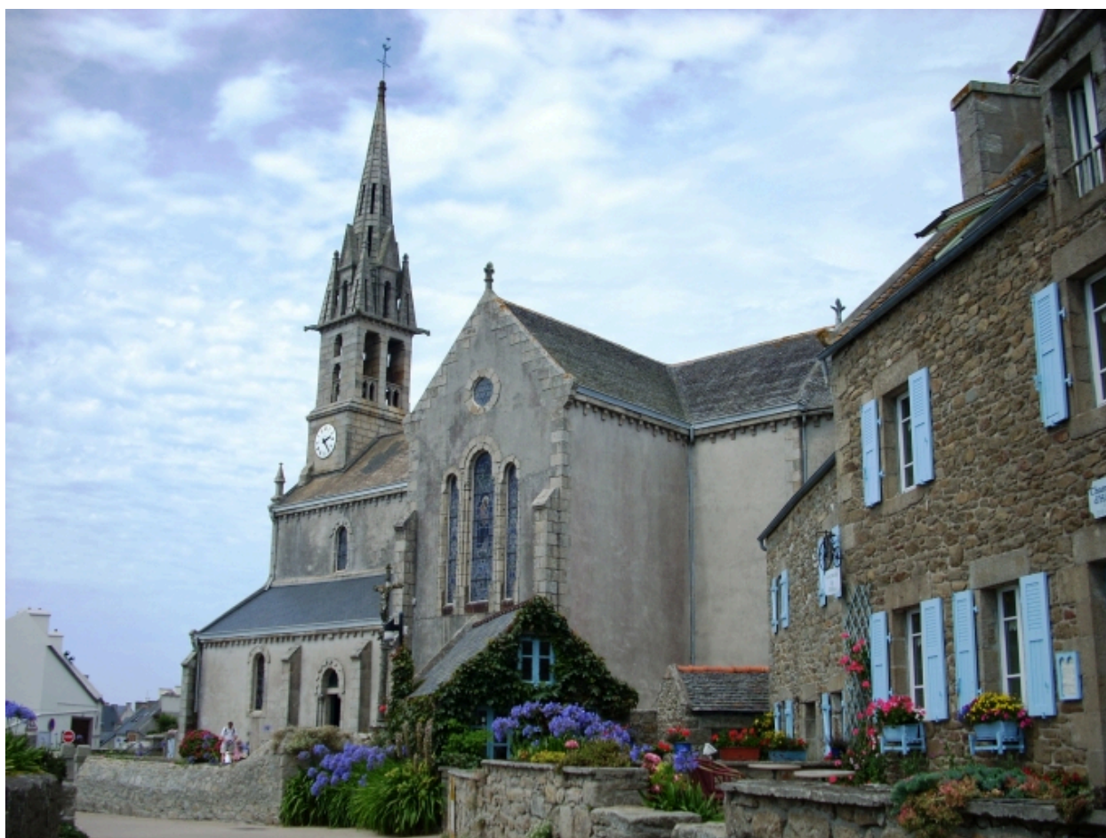
Ile de Batz, église paroissiale Notre-Dame : vue générale sud-est
