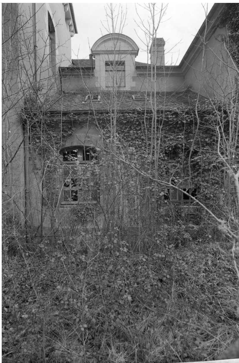
Elévation nord, détail de l'appentis ouest.
