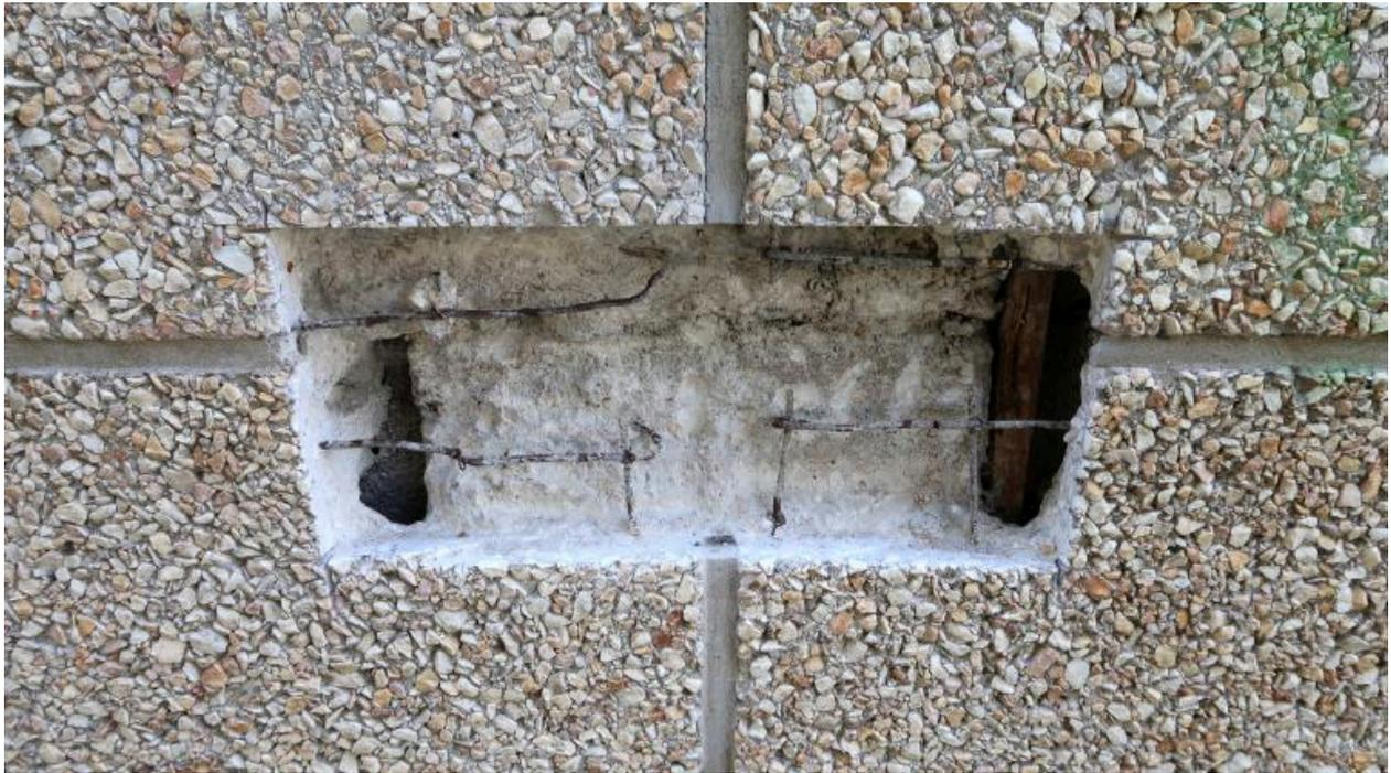
Système d'accrochage des panneaux de parement de façade, préfabriqués, en béton et gravier lavé. On aperçoit la structure (poteau en béton armé) et les parpaings en ciment utilisés pour le remplissage entre deux poteaux de la trame.
