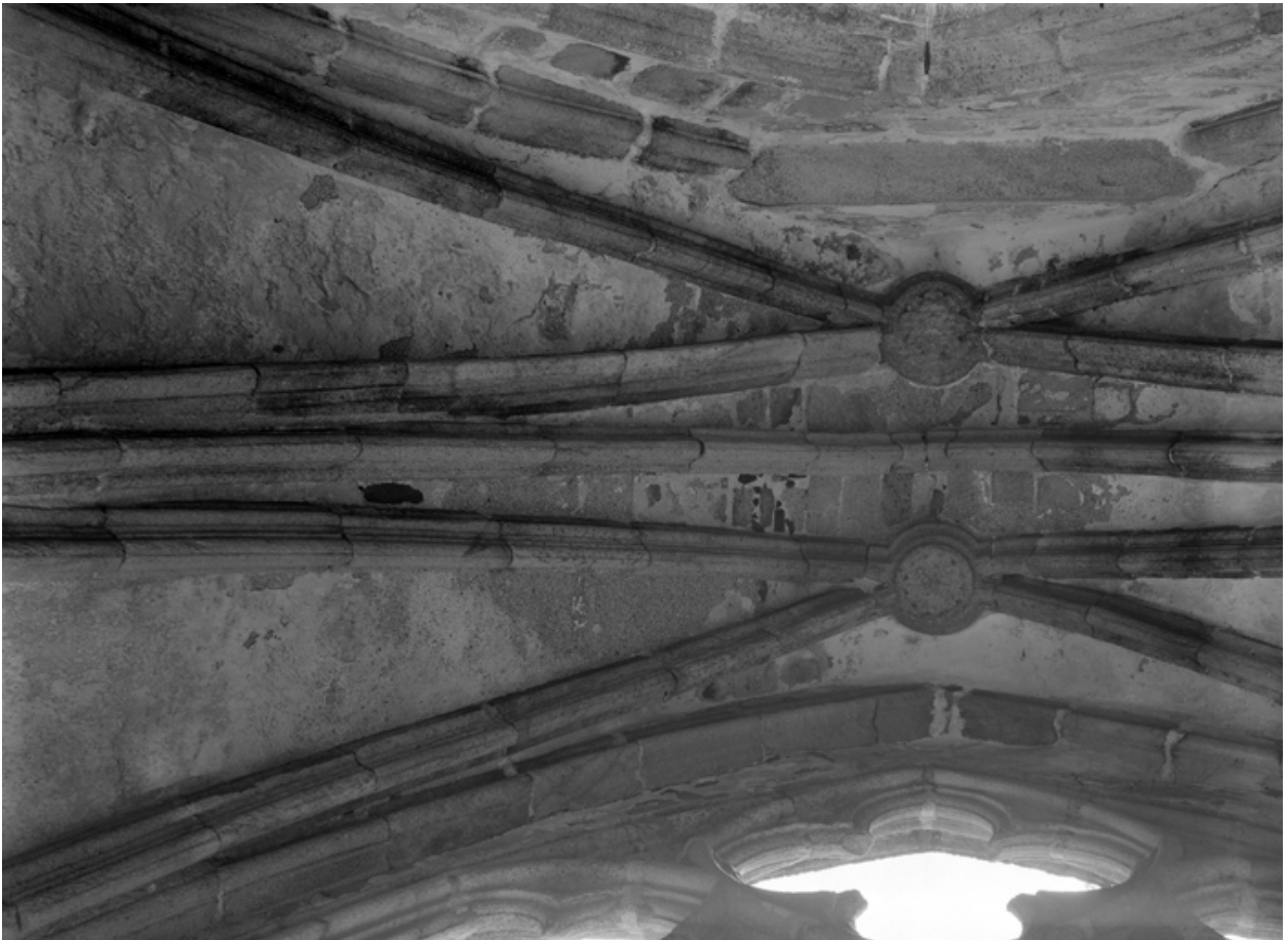
Porche sud, voûte
