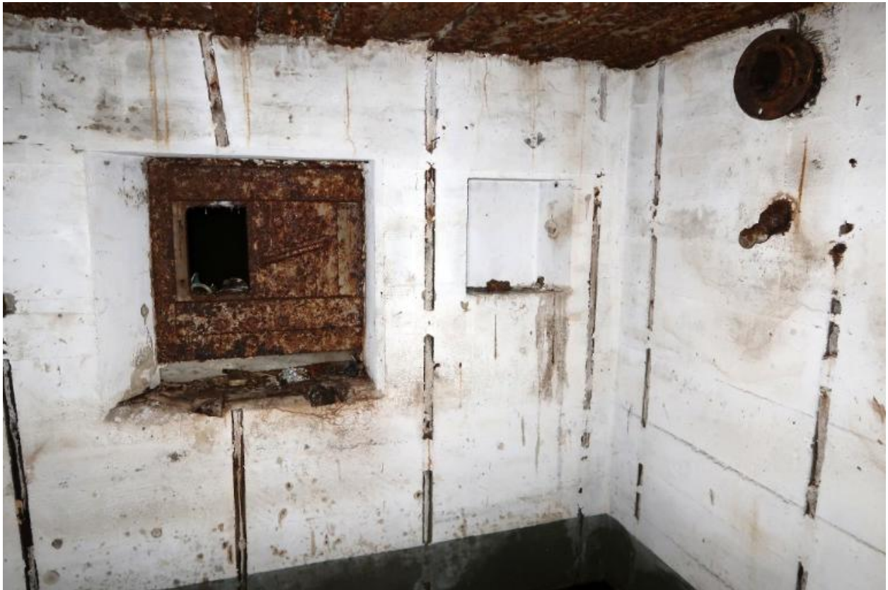
Vue intérieure : salle de garde sud, angle sud-est, créneau blindé de defense d'entrée et niche murale
