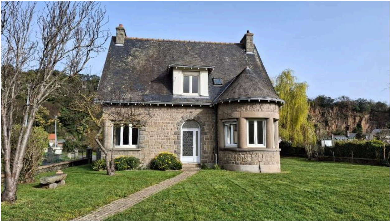
Maison dite du Commandant, à usage de bureaux, élévation principale
