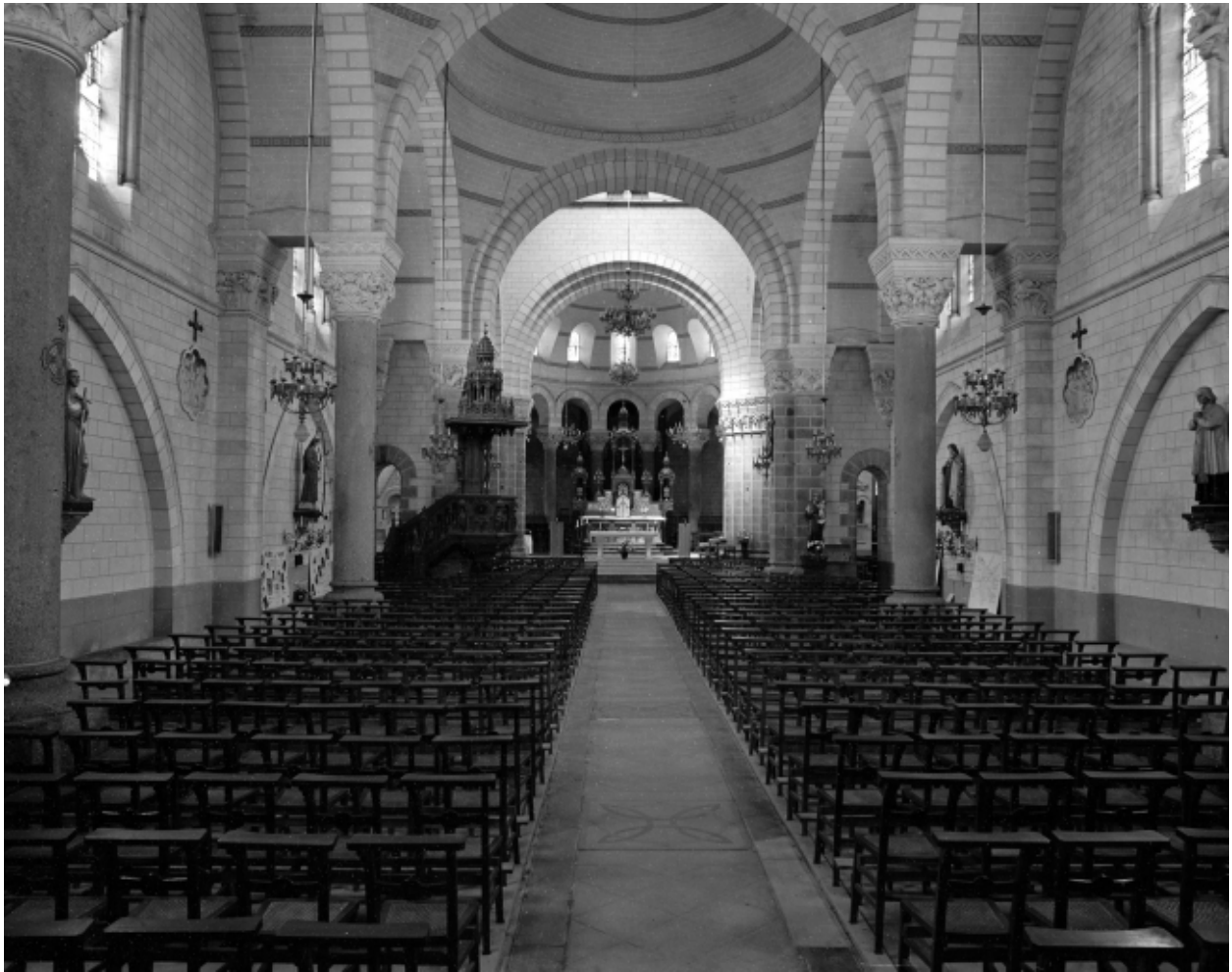
Vue générale de la nef vers le choeur.
