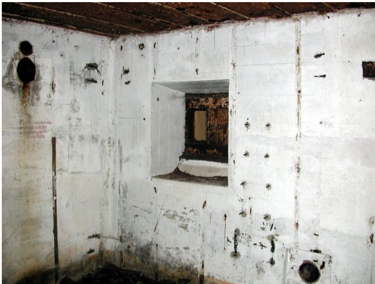
Vue intérieure : créneau blindé et marquages (état en 2003)
