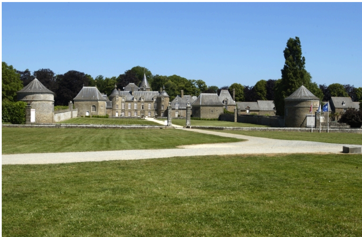
Vue générale sud
