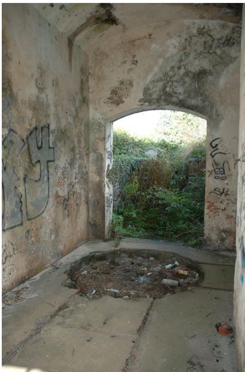
Vue des casemates de projecteur (état en 2007)
