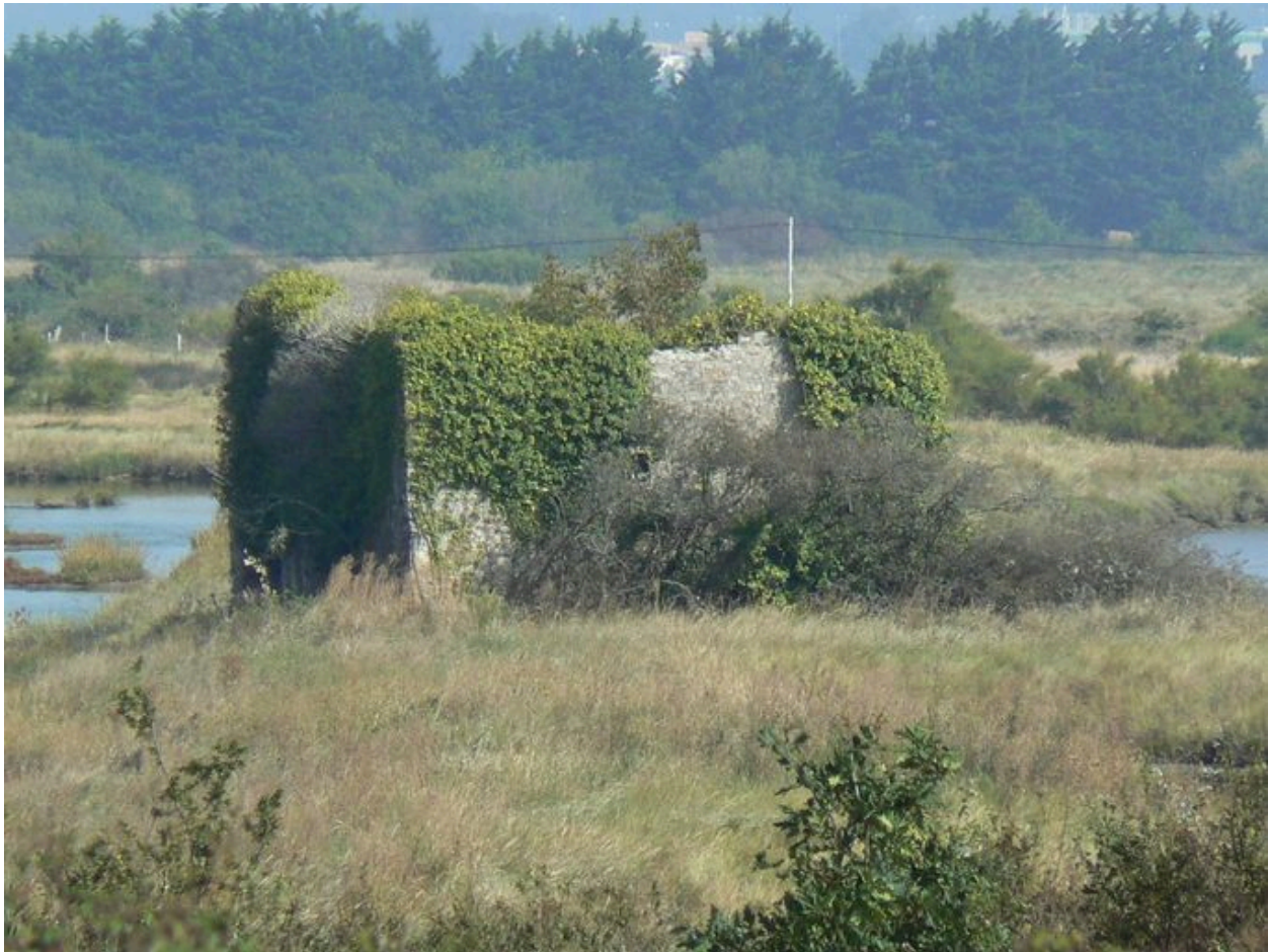
Vue générale du grenier à sel dit salorge de Michotte
