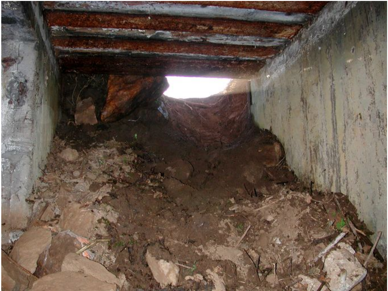
Vue de l'entrée ouest. Elle est partiellement remblayée
