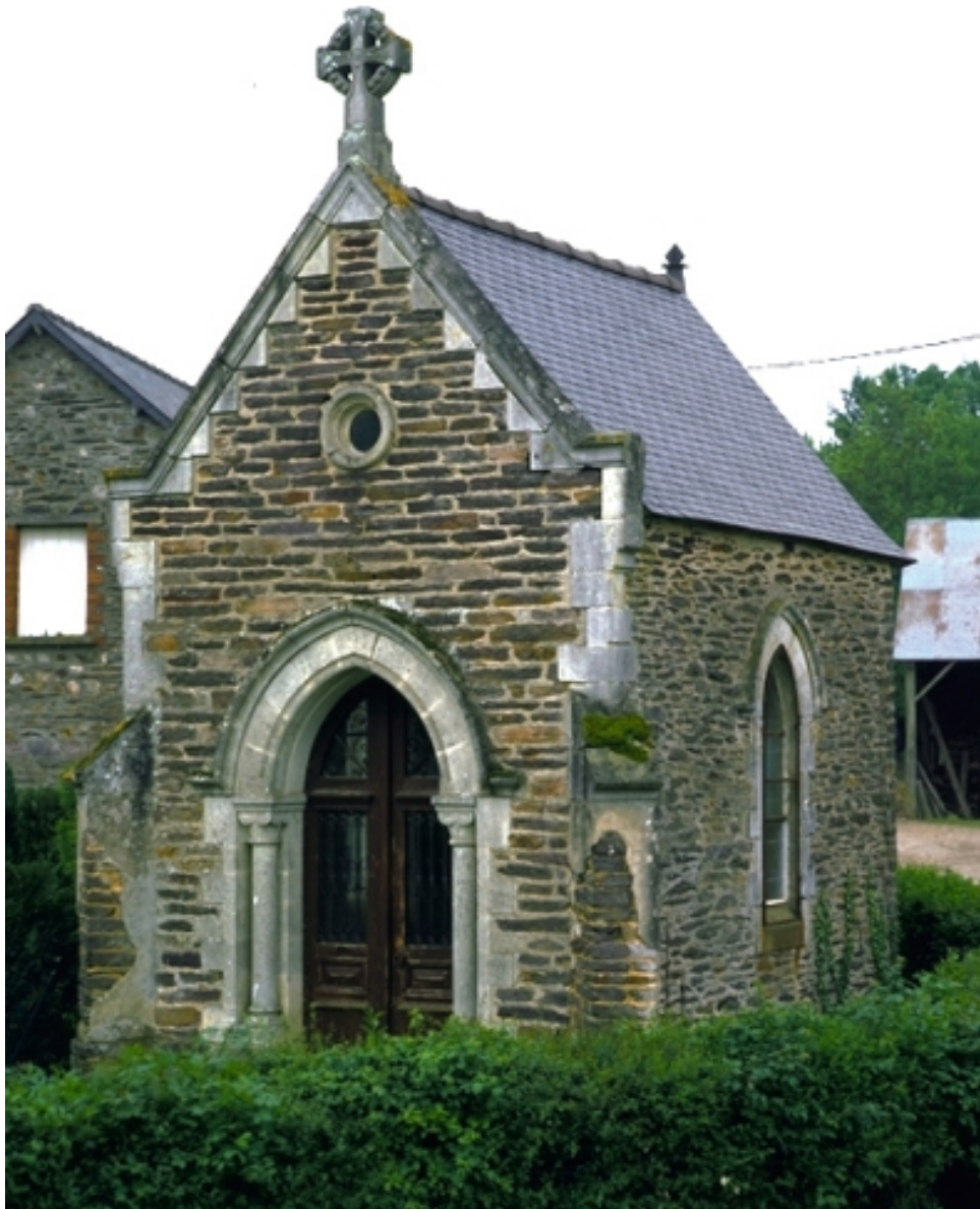
Façade nord : vue générale
