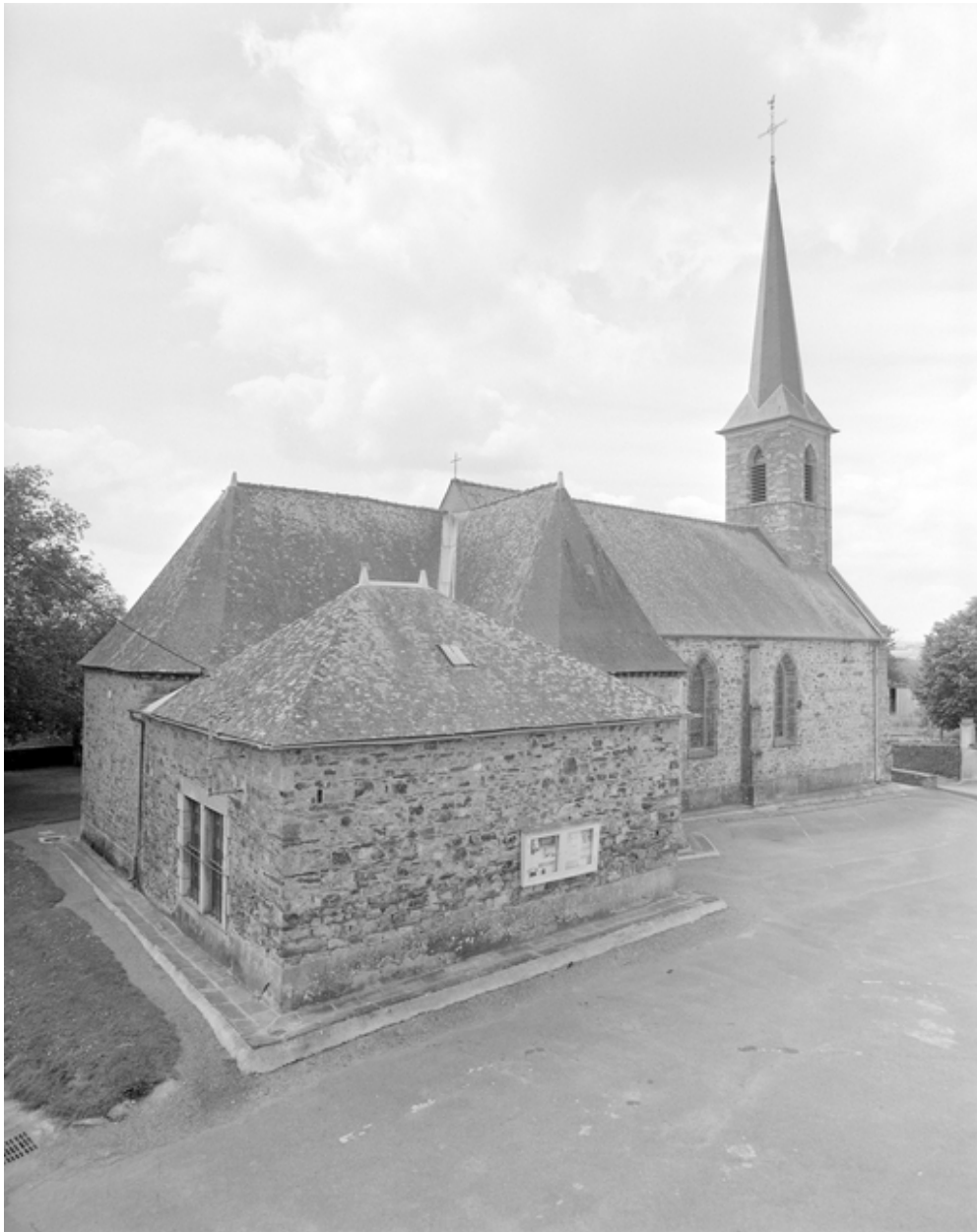
Le chevet avec la sacristie : vue générale nord-est
