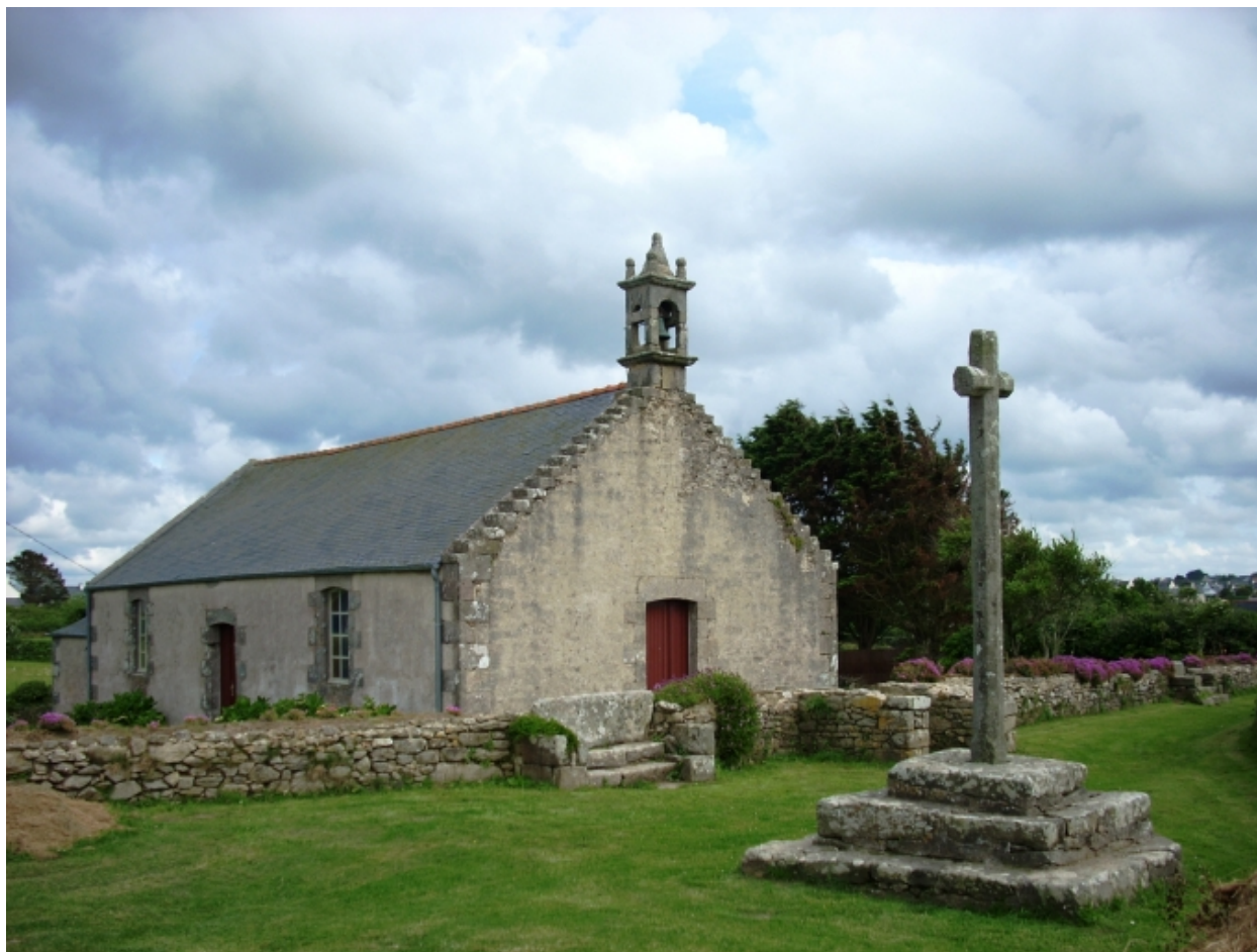
Landeda, chapelle Sainte-Marguerite : vue générale nord-ouest
