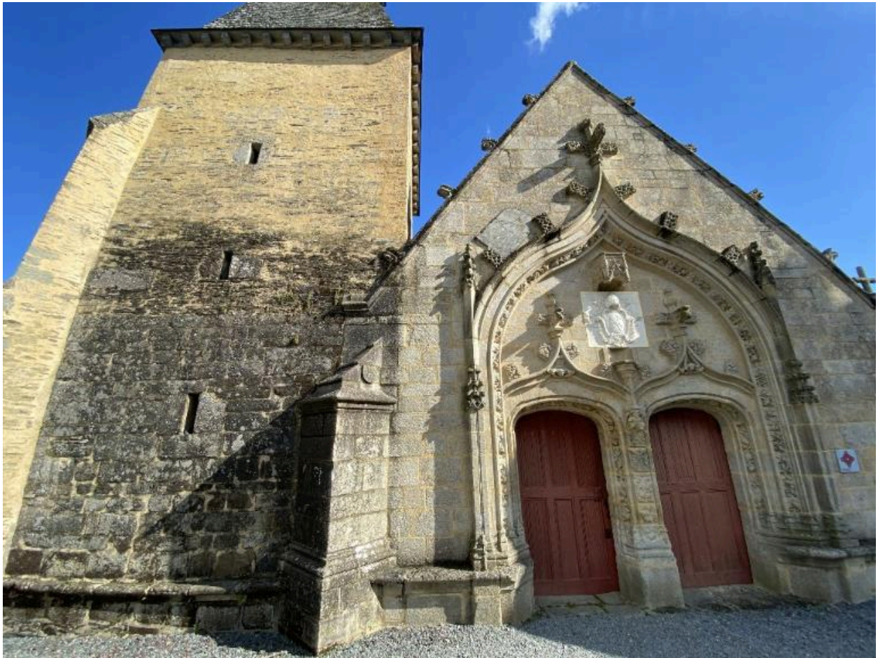
Élévation ouest, vue générale
