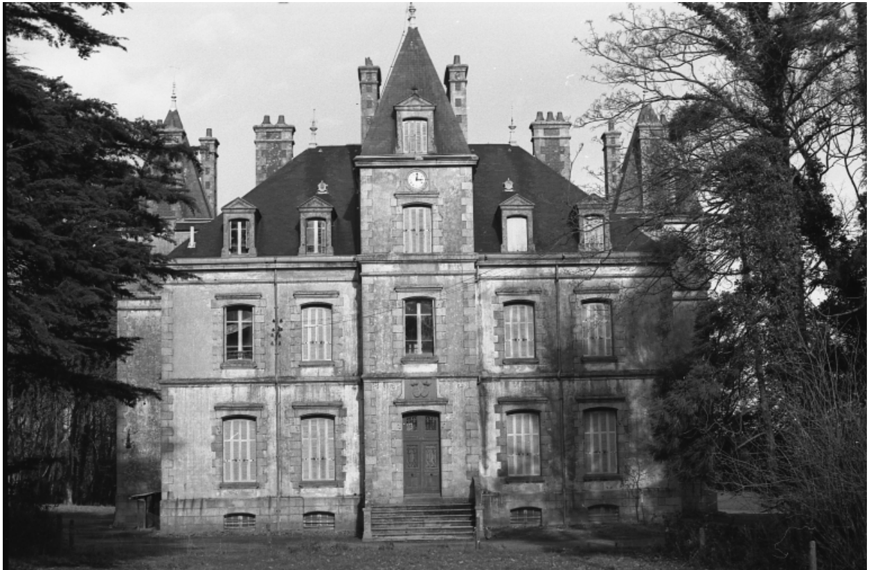
Elévation ouest : vue générale
