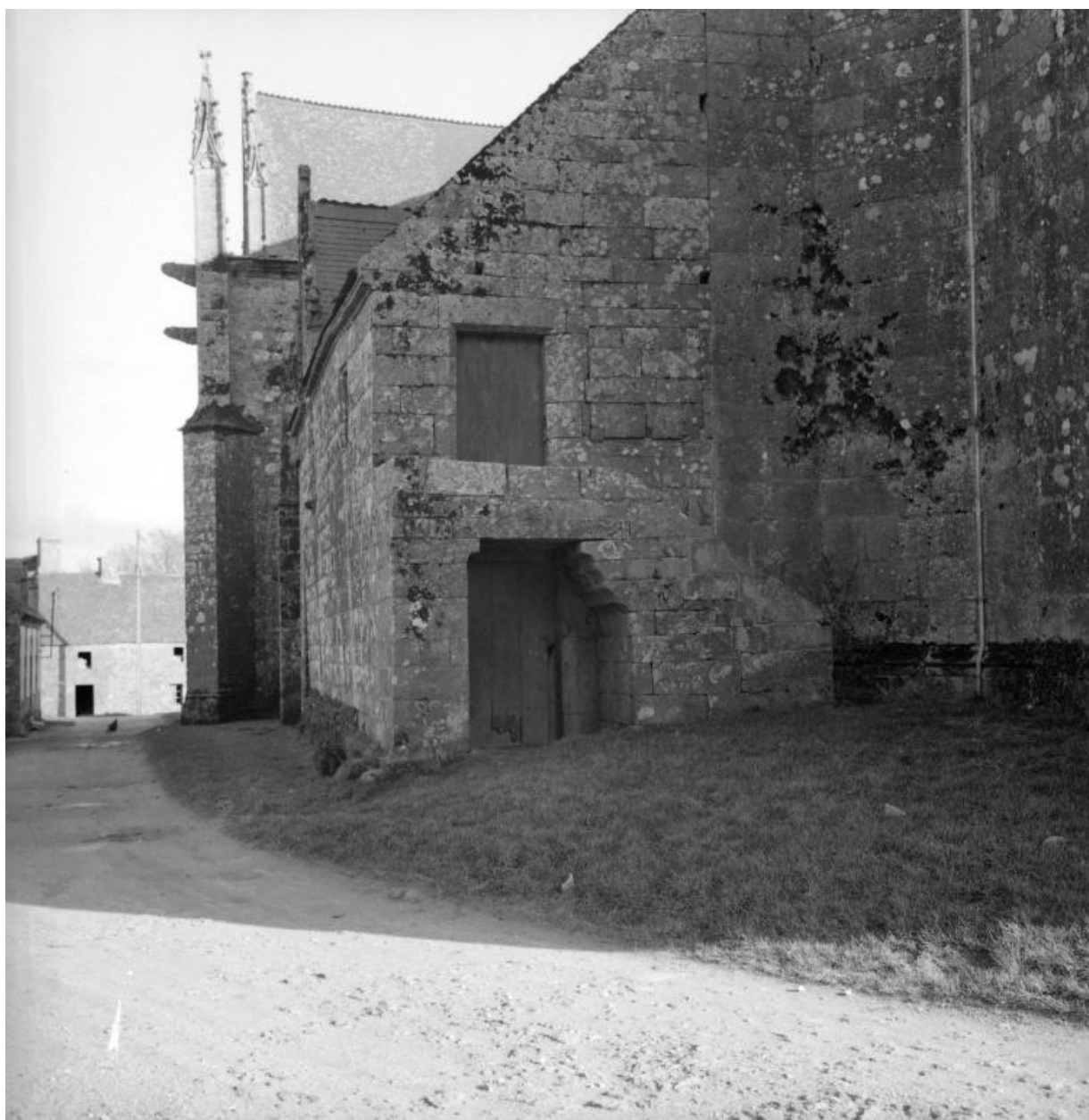
Porte et escalier de l'extrémité nord-ouest de la nef.
