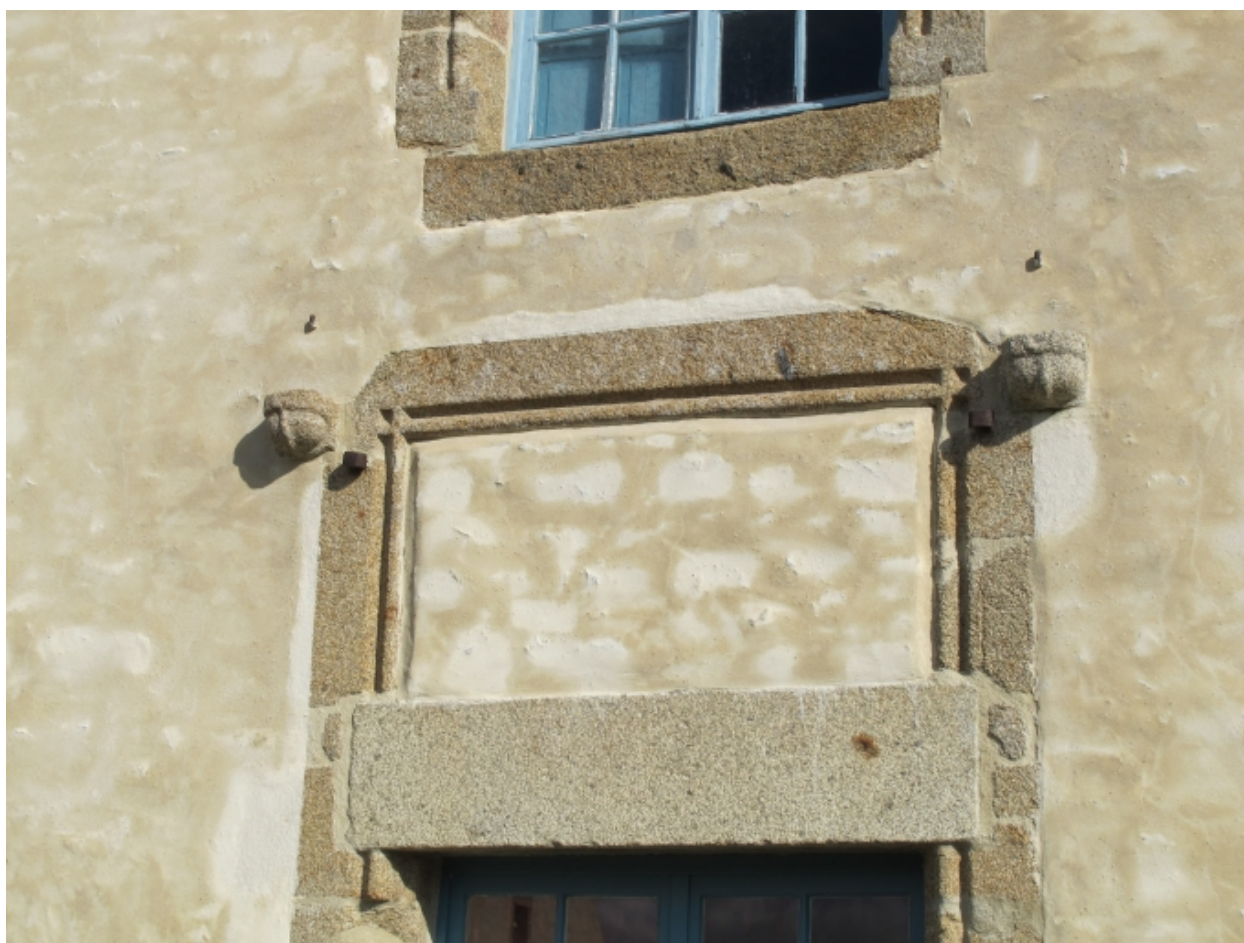
Détail de l'une des baies de la façade
