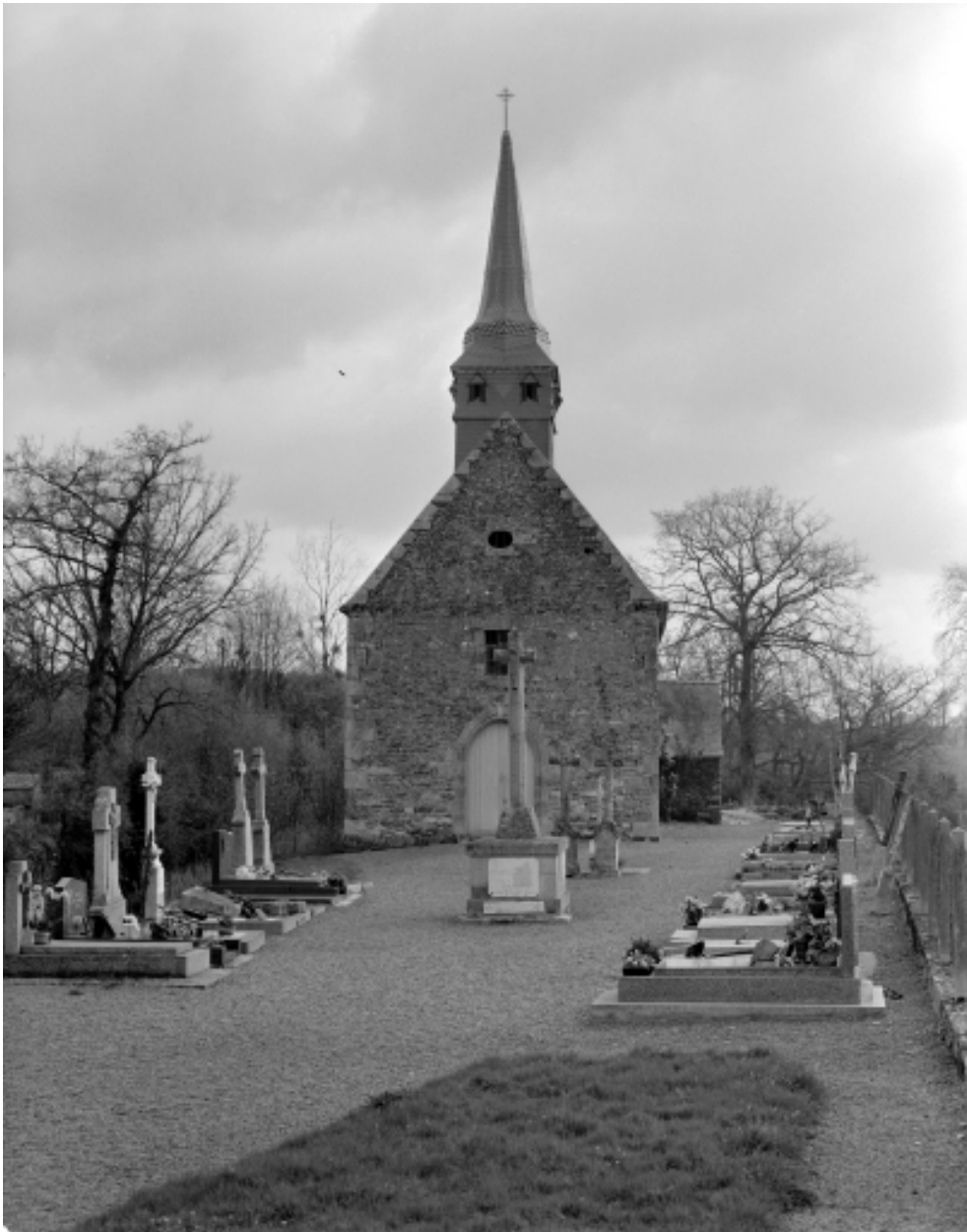
Elévation Ouest : vue générale
