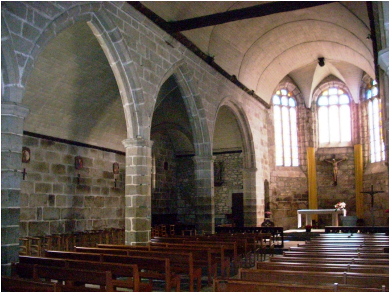
Huelgoat, église paroissiale Saint-Yves : vue transversale nord-est
