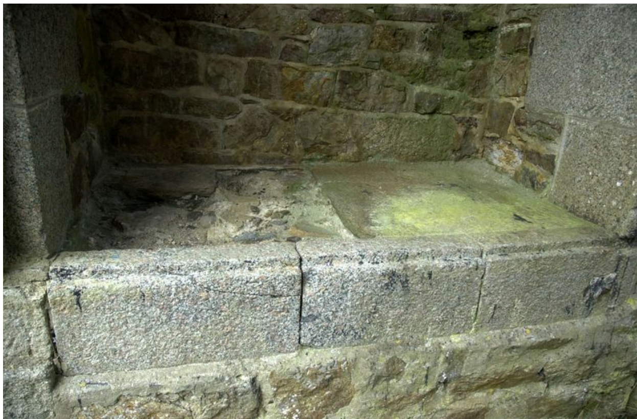
Vue de détail de la porte monumentale datée de 1878 (état en 2007)
