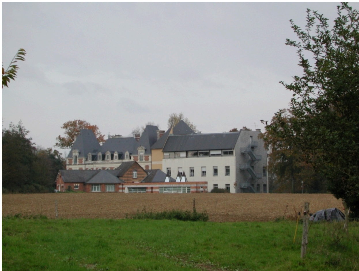
Vue de situation sud
