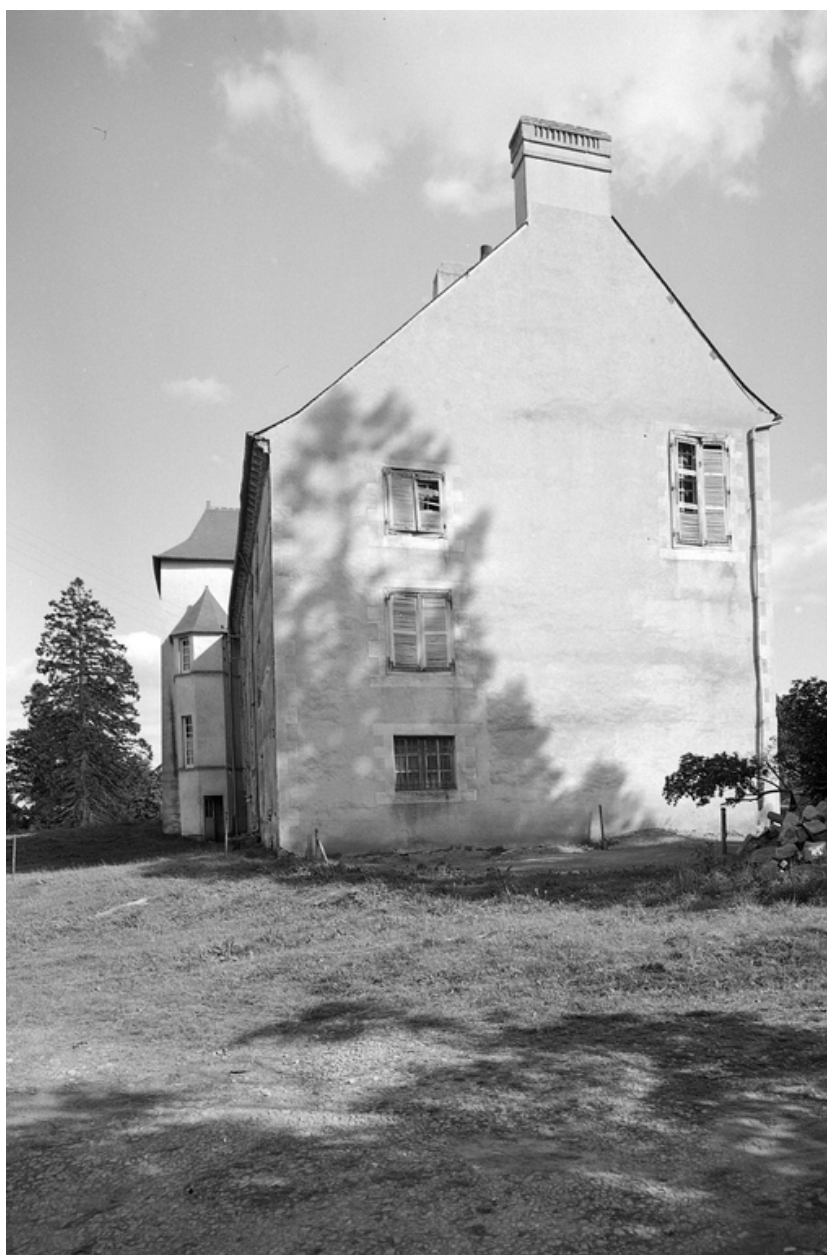
Vue générale, façade ouest.
