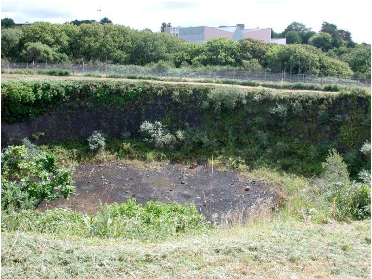
Vue de l'un des encuvements du parc à carburant de Maison Blanche
