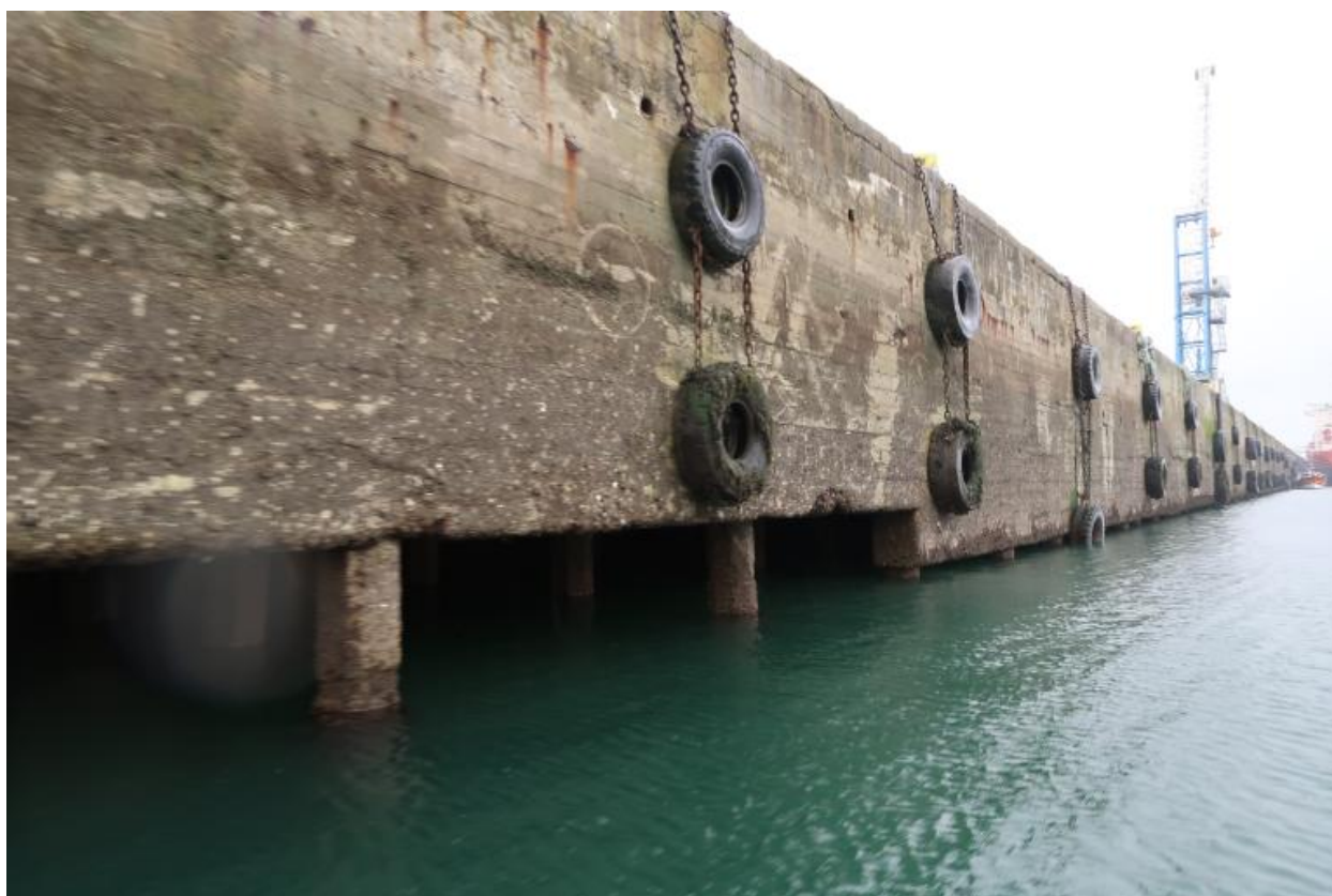
Quai est, 5e bassin
