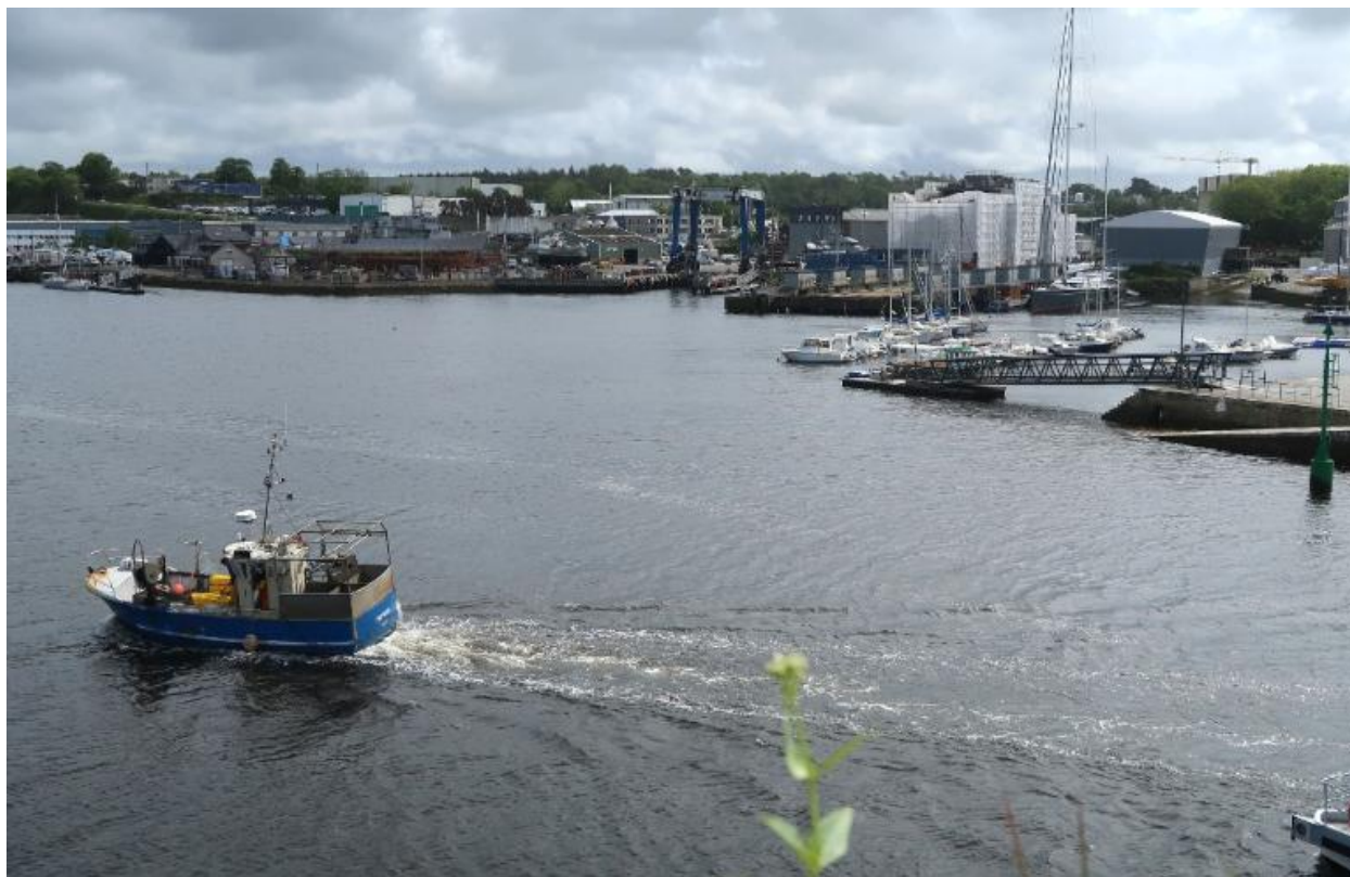
L'aire de réparation navale de Concarneau
