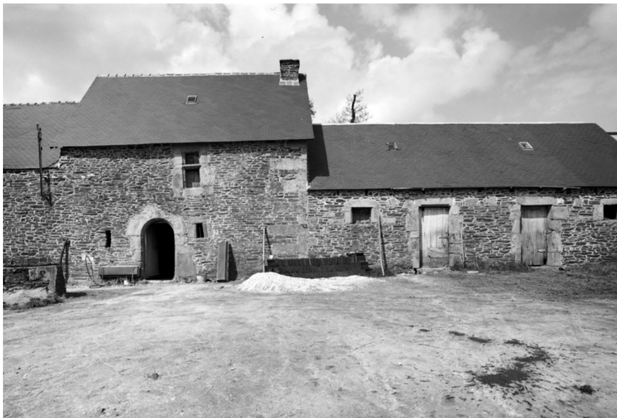
Vue générale façade sud
