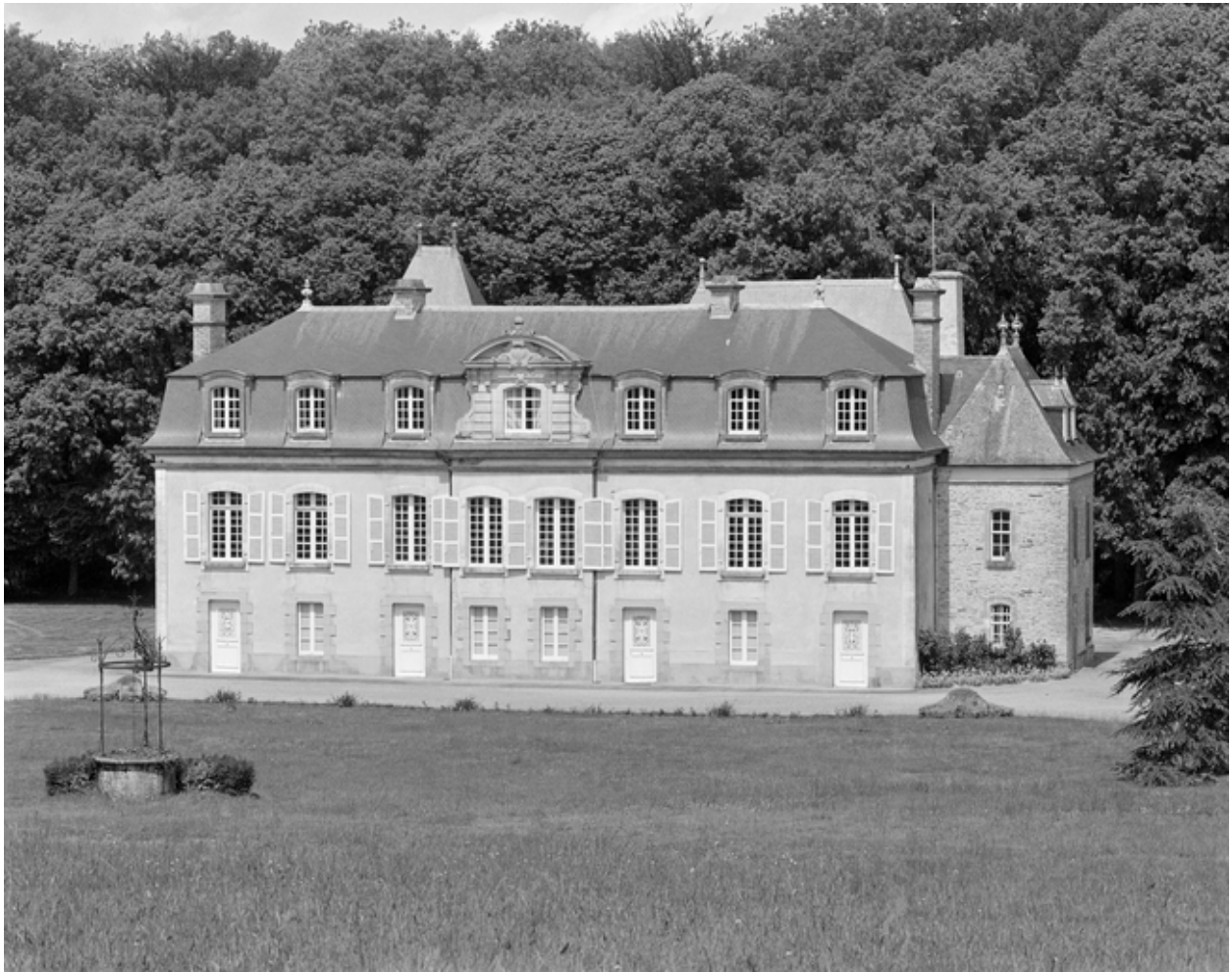
Elévation antérieure, vue générale.
