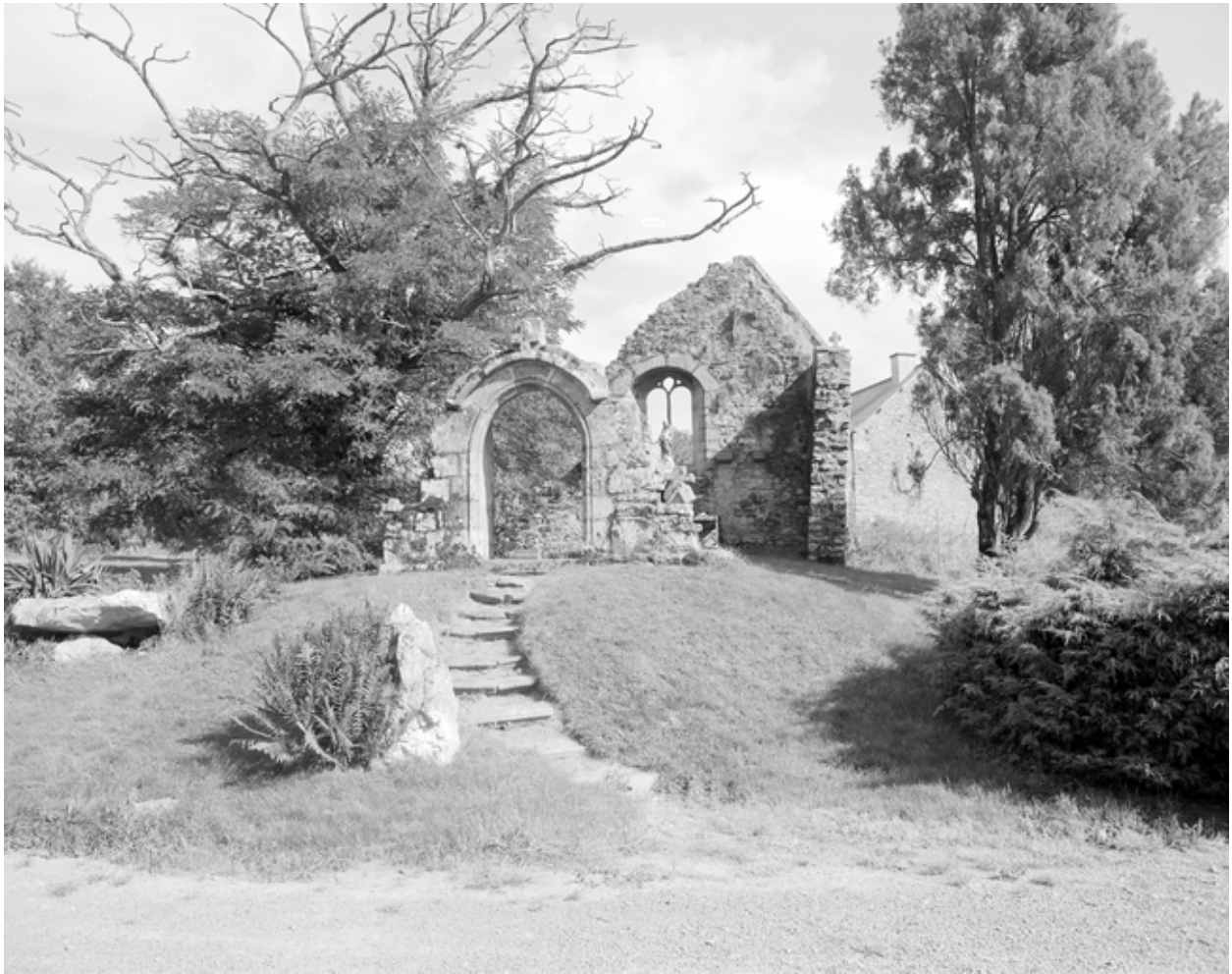
Chapelle, vue générale sud.
