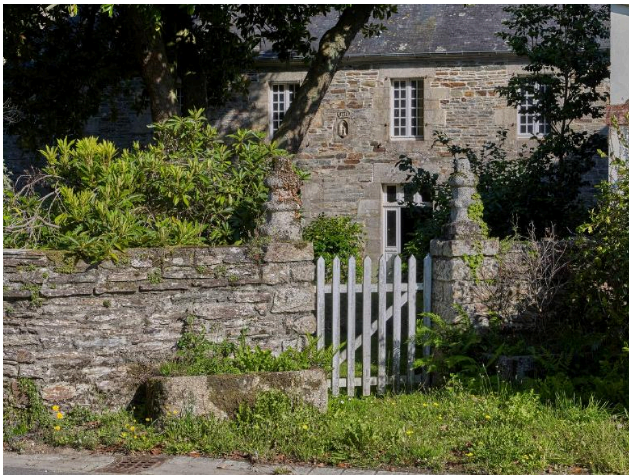
Mur et entrée de la cour avant. Vue sud depuis la rue des Lavandières
