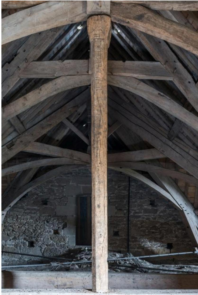
Vue d'ensemble du poinçon de la ferme orientale de la charpente du choeur.
