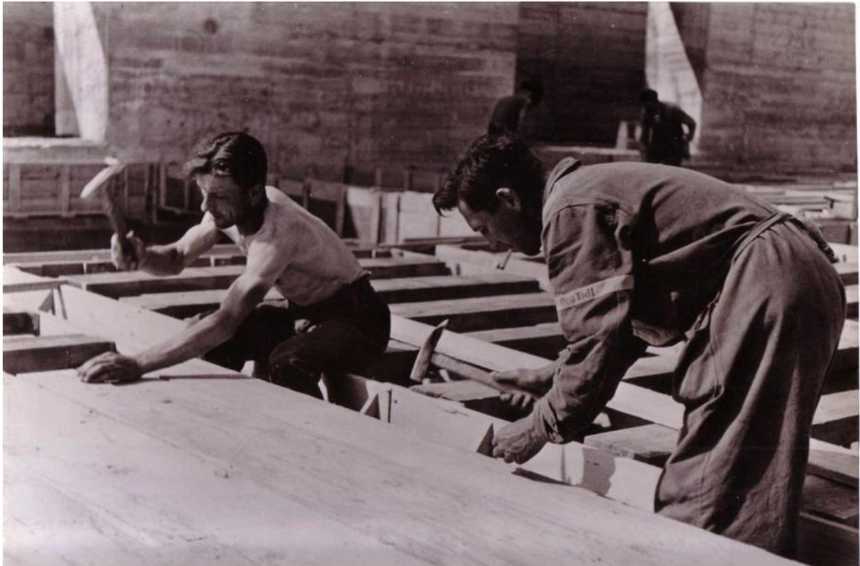
Image de propagande nazie : "Des luxembourgeois à la construction du plafonnage de bois pour l'entrevoûte de béton dans une soute d'atelier" [travailleurs de l'organisation Todt]
