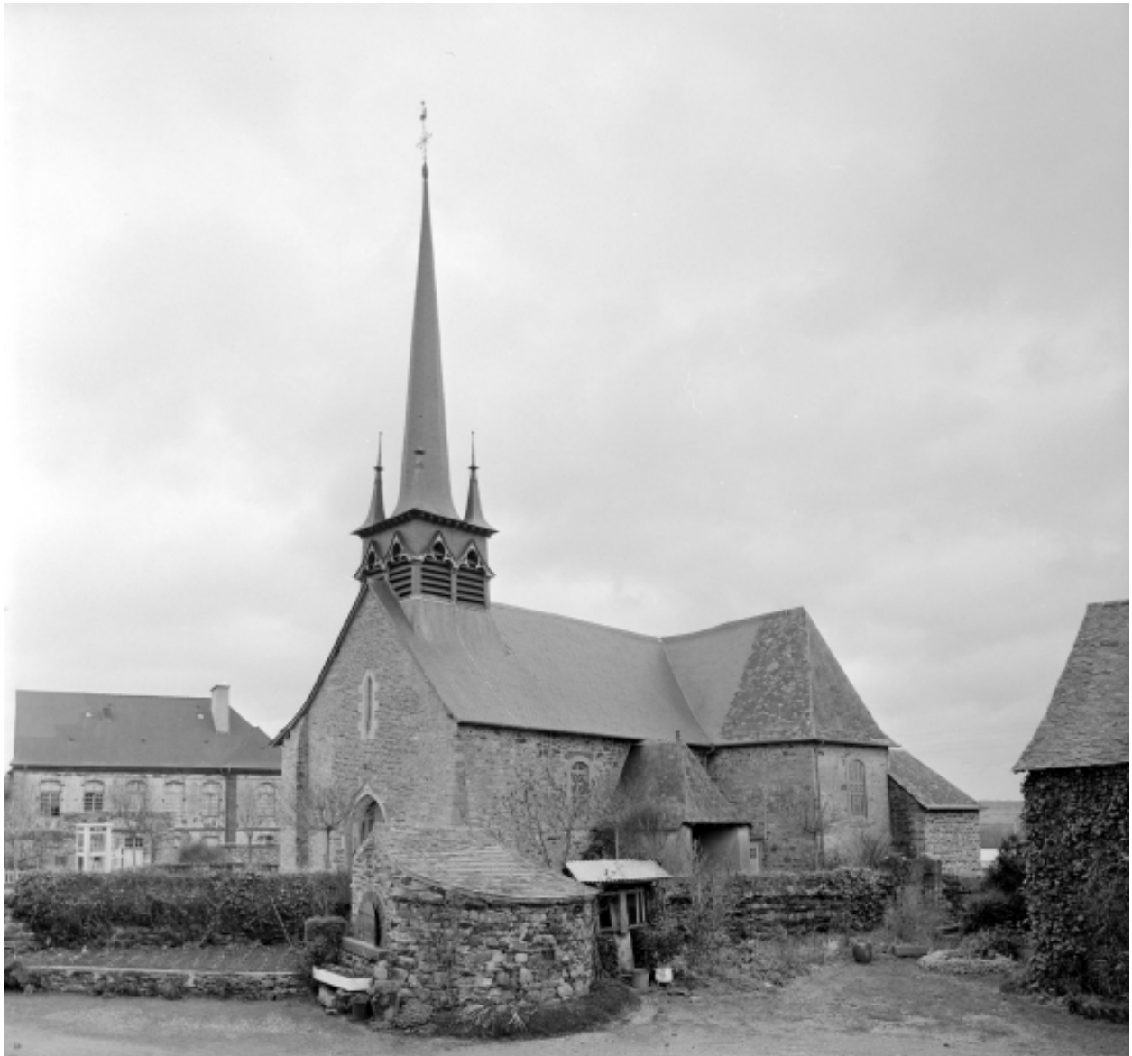
Elévation sud-ouest : vue générale
