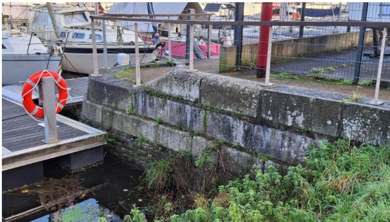
Détails de maçonnerie de l'ancienne aire d'évitage
