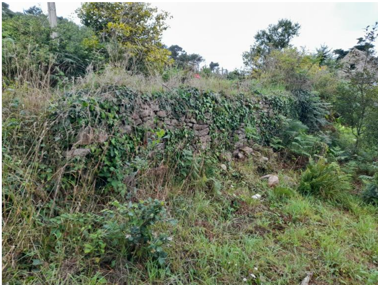
Mur 1, soutènement. Côté est.
