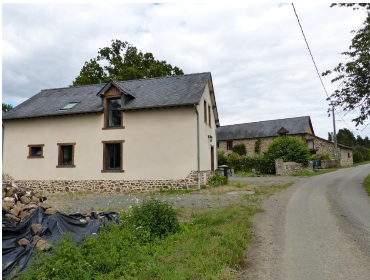
Vue générale, Bêlême (Hédé-Bazouges)
